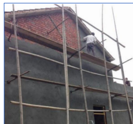
未挂设安全网、单排支撑、未设置剪刀撑
