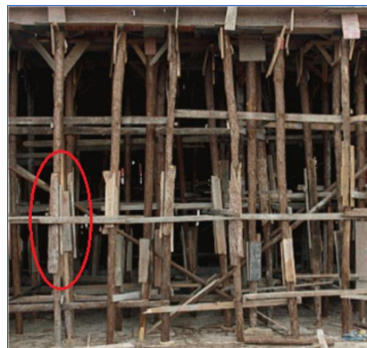
立杆采用对接夹板接头
