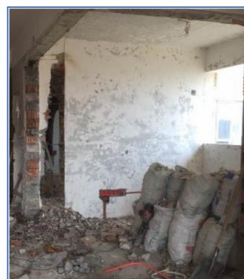
违规在楼板上集中堆放建筑垃圾、废渣
