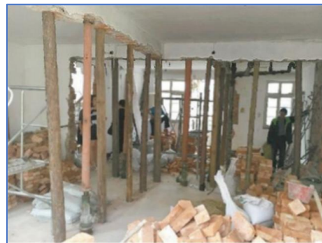
违规拆除承重墙
