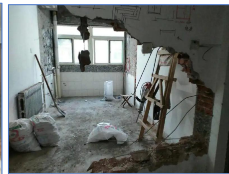
违规拆除承重墙
