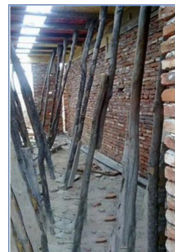
立杆未采用对接夹板接头
