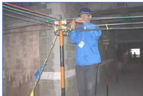
电线线缆架空保护 ✓
